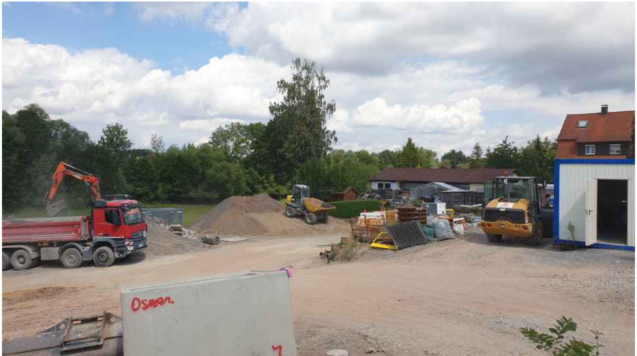
Abbildung 24 Baustelleneinrichtung auf Flurstück 414 + 413/3 (Foto 27.7.2022)
