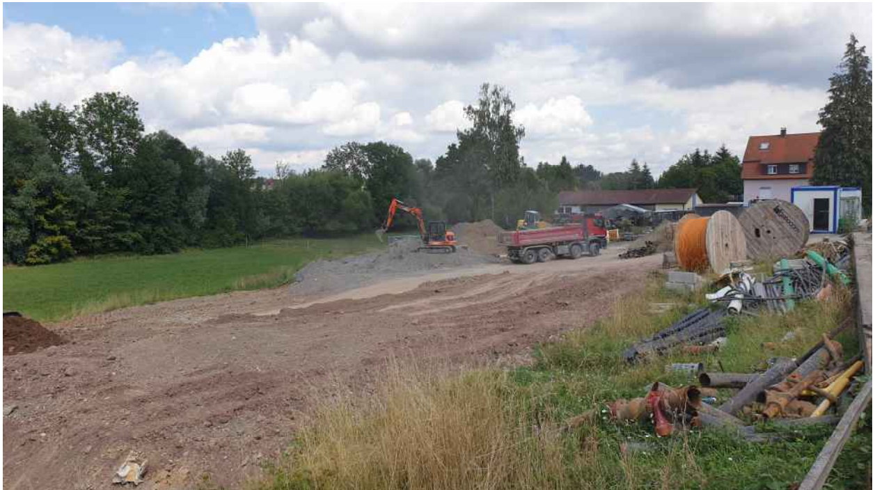
Abbildung 32 Ruderalvegetation innerhalb Eingriffsfläche im Osten des Flst. 414/3 (Foto 27.7.2022)
