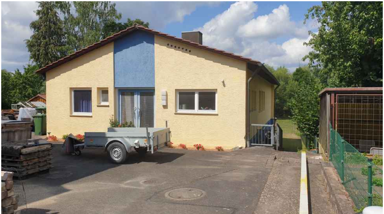
Abbildung 15: Der Hof vor Gebäude 64 (Flurstück 412/1) ist asphaltiert (Foto vom 27.7.2022)
