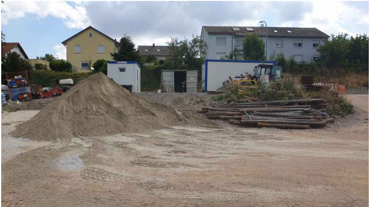
Abbildung 30 Ruderalvegetation innerhalb Eingriffsfläche im Osten des Flst. 414/3 (Foto 27.7.2022)
