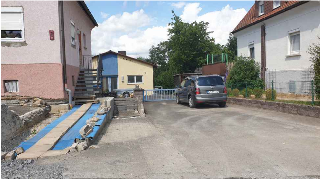
Abbildung 14: Die Zufahrt zu Gebäude 64 (Flurstück 412/1) ist asphaltiert (Foto vom 27.7.2022)
