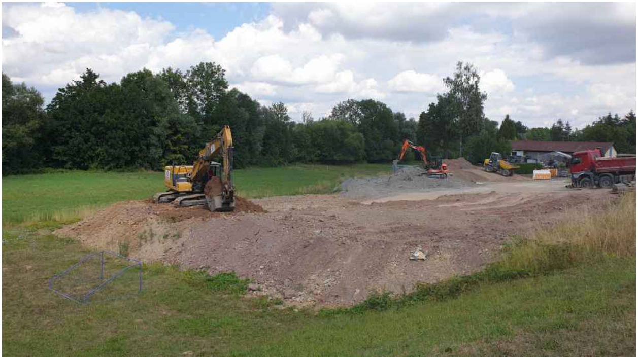
Abbildung 31 Ruderalvegetation innerhalb Eingriffsfläche im Osten des Flst. 414/3 (Foto 27.7.2022)
