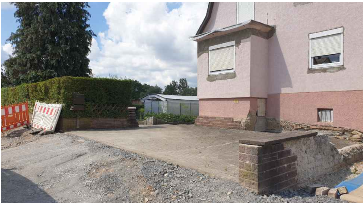
Abbildung 21: Pflasterfläche vor Gebäude auf Flurstück 412/1 (Foto 27.7.2022)
