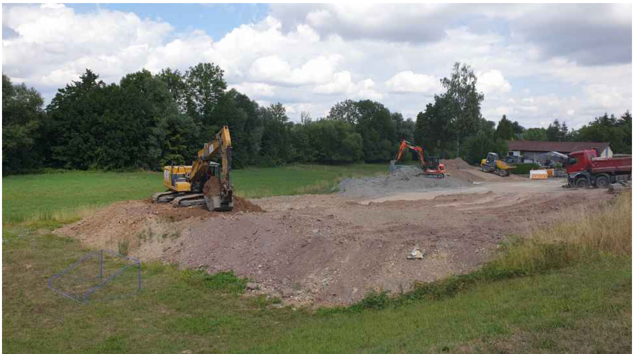
Abbildung 23: Bodenlagerung und Baustelleneinrichtung auf Flst. 414 + 413/3 (Foto 27.7.2022)
