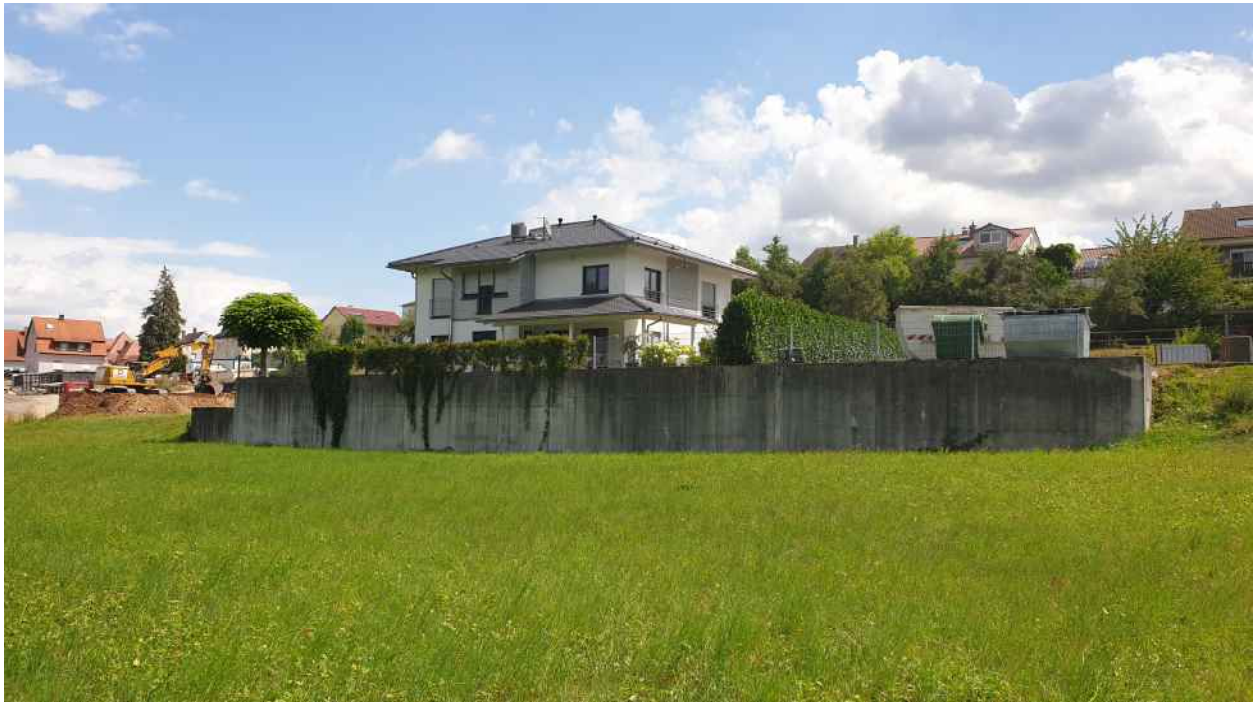
Abbildung 11: Wohngebäude auf Flurstück 423/1 und 423/2 (Foto 27.07.2022)
