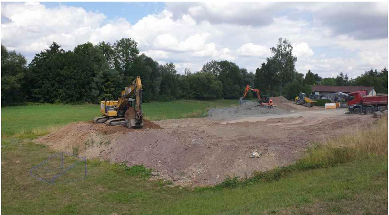
Abbildung 23: Bodenlagerung und Baustelleneinrichtung auf Flst. 414 + 413/3 (Foto 27.7.2022)
