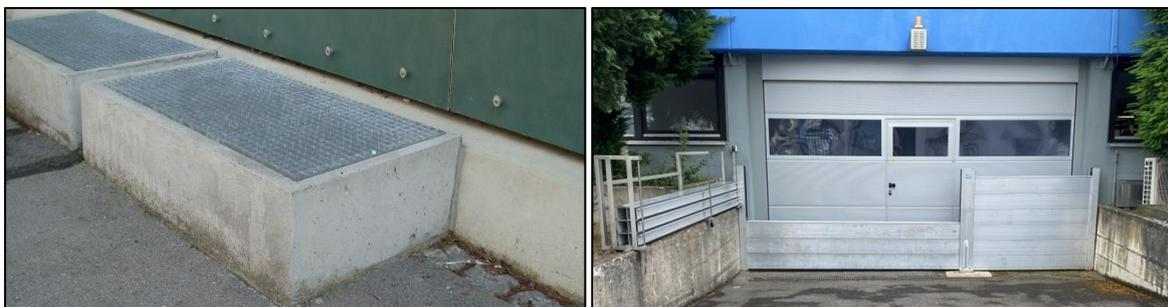
Abbildung 27: Umsetzungsbeispiel Aufkantung Lichtschacht<sup>14</sup> (links); Umsetzungsbeispiel Objektschutz durch Dammbalken (rechts)
