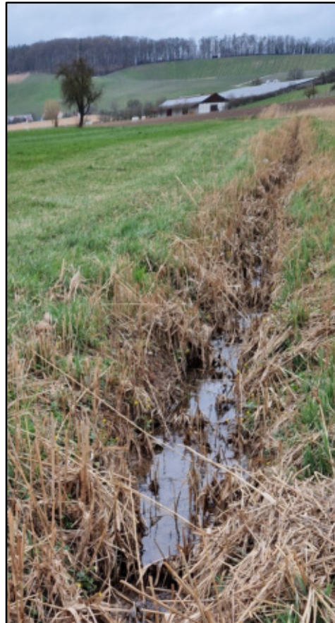
Oberhalb HRB begradigt, ausgebaut, überwachsen, Uferbereich „durchschilft“; Böschungsmahd und Sohlräumung ist erfolgt
