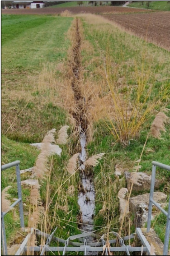
Oberhalb HRB begradigt, ausgebaut, überwachsen, Uferbereich „durchschilft“; Böschungsmahd und Sohlräumung ist erfolgt
