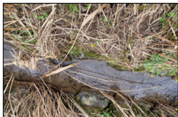
Uferverbau: keine Unterstände vorhanden
