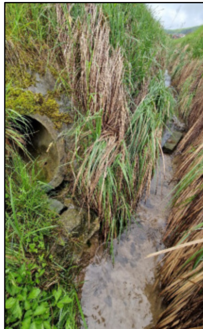
wie oben; in Fließrichtung von rechts mündet Rohr vermutlich aus der Straßenentwässerung
