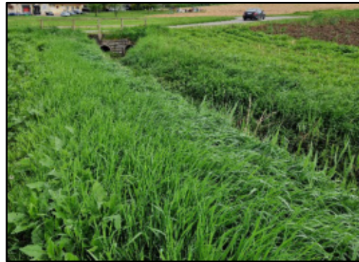
RWA-Einmündungsbereich obere Brücke
