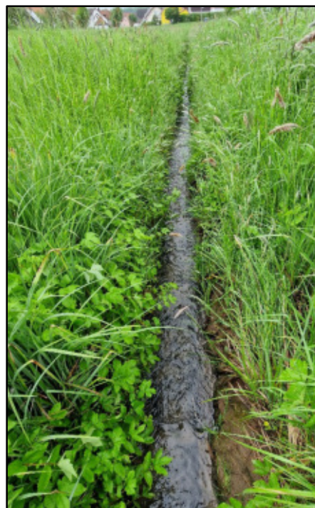
ausgebauter Abschnitt oberhalb Schwabbach
