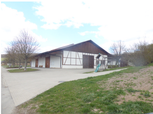
Abb. 18: Südliches Betriebsgebäude mit Dachüberständen an beiden Traufseiten.
