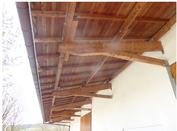
Abb. 19: Südliches Betriebsgebäude mit Dachüberstand ohne Vogelnest.
