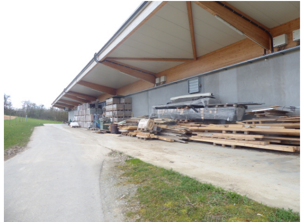
Abb. 21: Nördliches Betriebsgebäude mit Dachüberständen an beiden Traufseiten.
